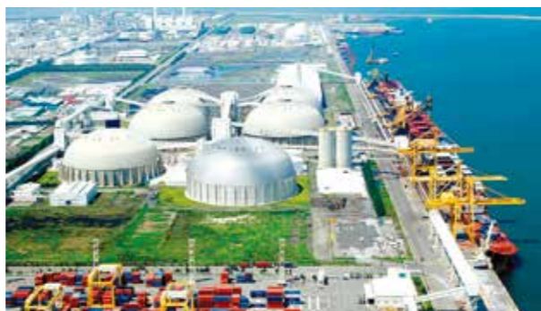
台塑海运 麦寮港运煤船
