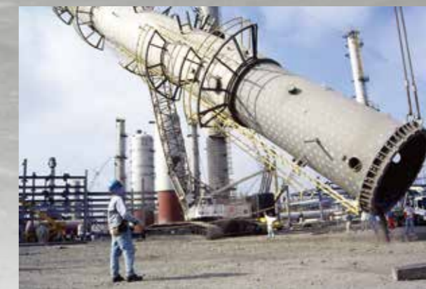
厂房与塔槽安装
